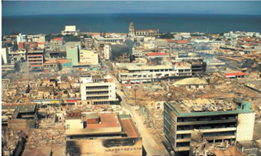
Fig. 8. Centro comercial de Managua devastado por el más fuerte terremoto del siglo XX, en 1972. Fuente: Diario La Prensa/Archivo.
