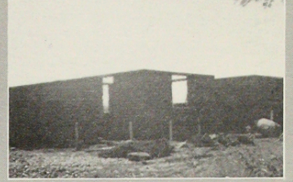
Muros y sus refuerzos.
