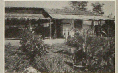
Vista desde el huerto al corredor de trabajo.
