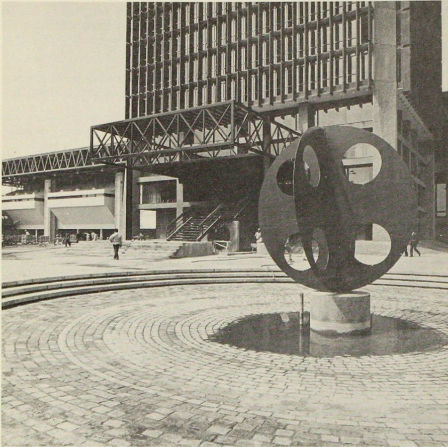
Plaza de Ingreso Edificio Diego Portales
