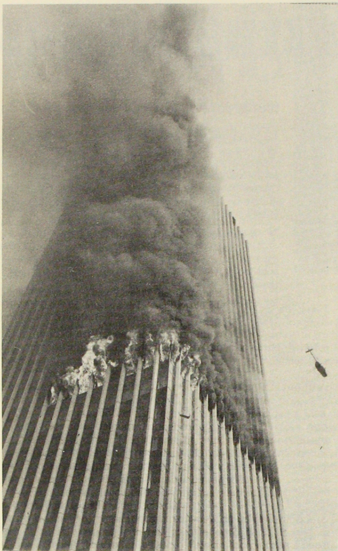
Incendio en la Torre Santa María, de enorme impacto en la conciencia ciudadana, al mostrar la vulnerabilidad de uno de nuestros más modernos y equipados edificios. Foto facilitada por Revista HOY.
