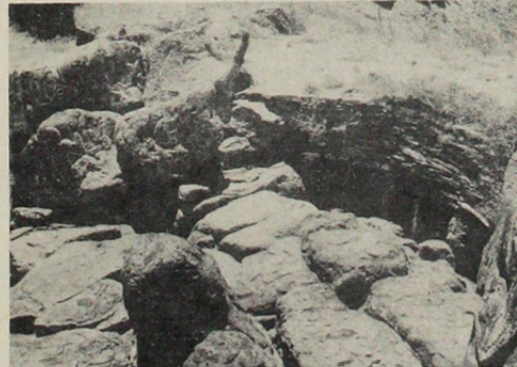
Vistas de las casas de Orongo antes y después de su restauración.
