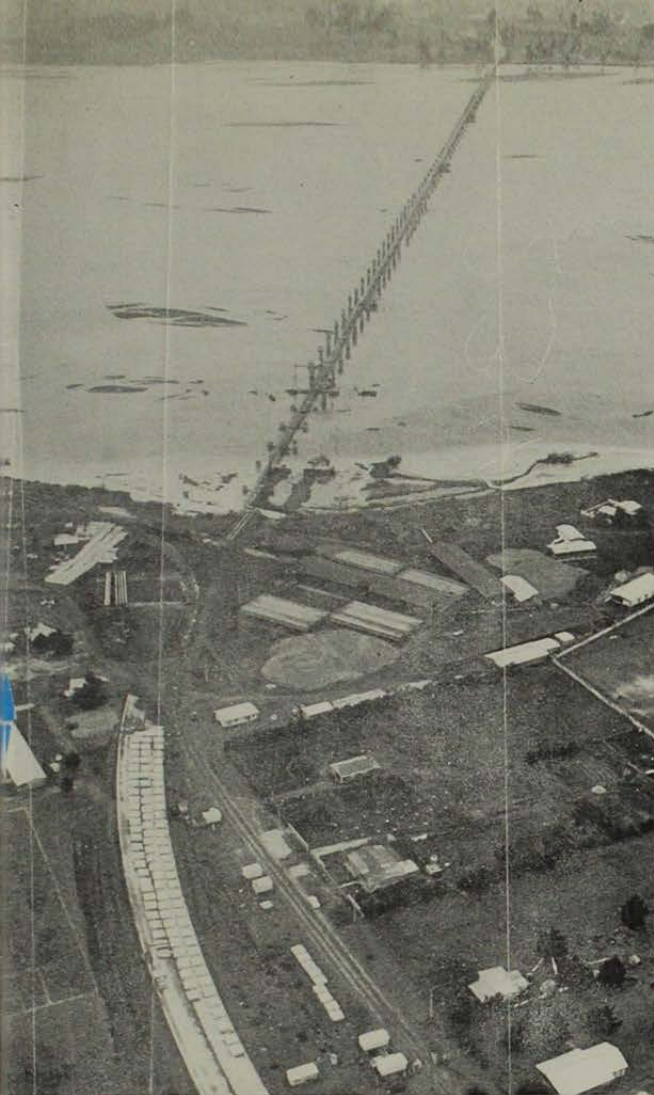
7. Nuevo Puente Carretero en construcción sobre el río Bío-Bío que conectará el centro Metropolitano de Concepción y sus servicios portuarios e industriales con el resto de la Región hacia Arauco.
