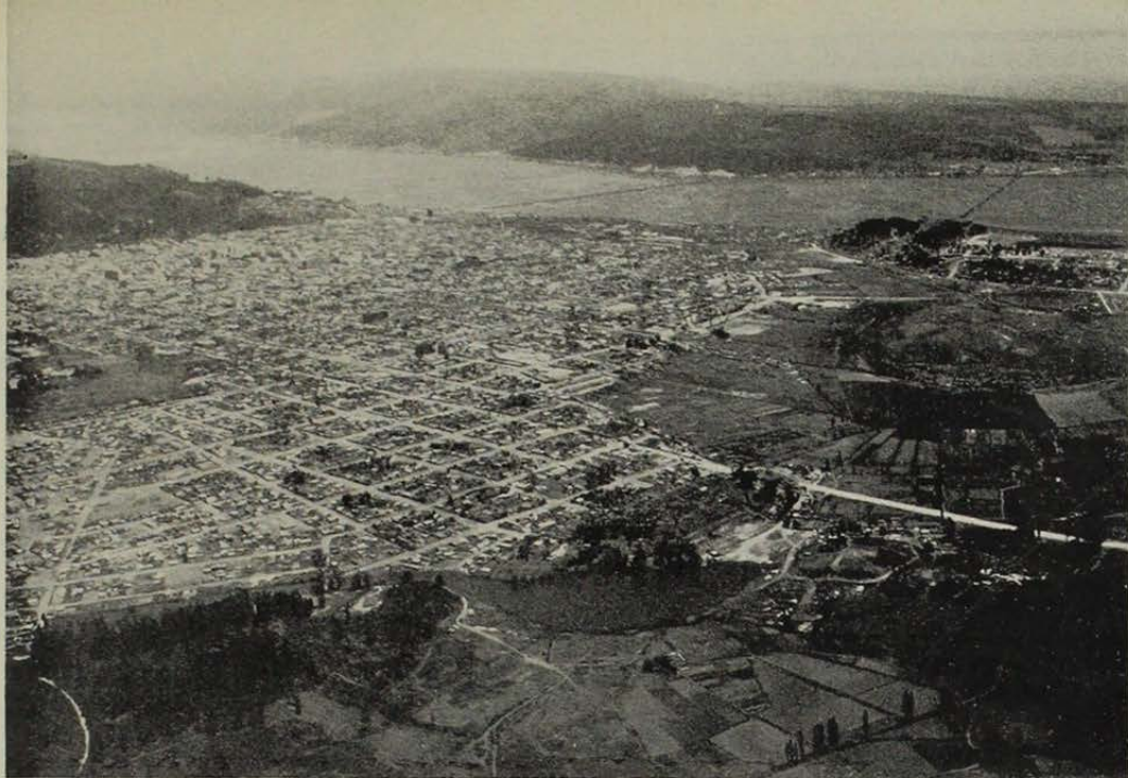
1. Emplazamiento de la ciudad de Concepción al borde del río Bío-Bío. Pueden observarse los puentes carretero y ferroviario que cruzan el río hacia San Pedro y Arauco. Al frente la cordillera de Nahuelbuta comienza a adquirir altura. En primer plano, autopista a Talcahuano.
