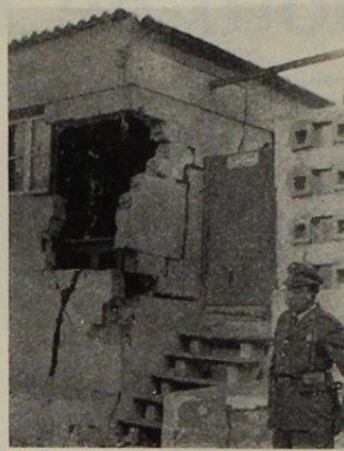
3 Población Sotomayor. Los muros estructurales de bloques estallaron. Los sobrecimientos sin refuerzos, no fueron capaces de contener la presión de los rellenos. (Foto G. Pueller).
